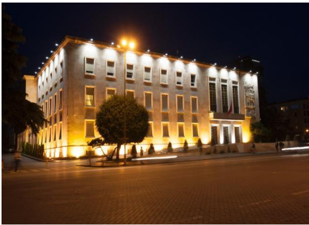
Ndërtesa e Kryeministrit - Tiranë
